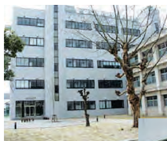
本館 Main Building
